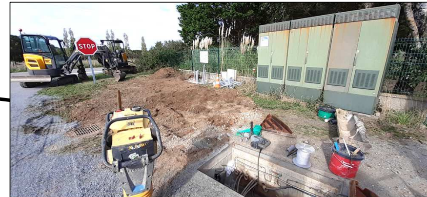
25-09-2023 – Travaux préparatoires à la pose du SRO à la Pitardais
