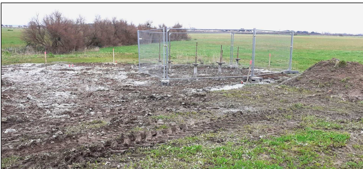
28 février – Pose des micropieux terminée
