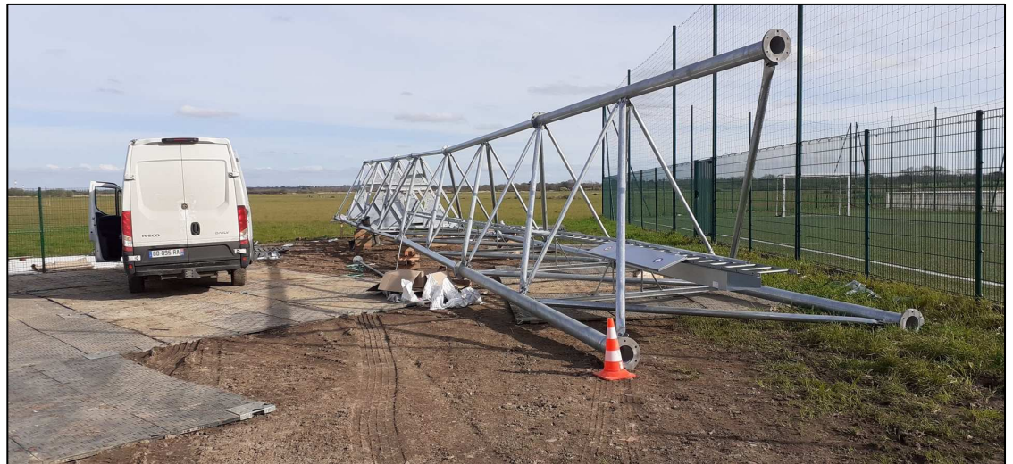
19 mars – Assemblage terminé : 24 m de long
