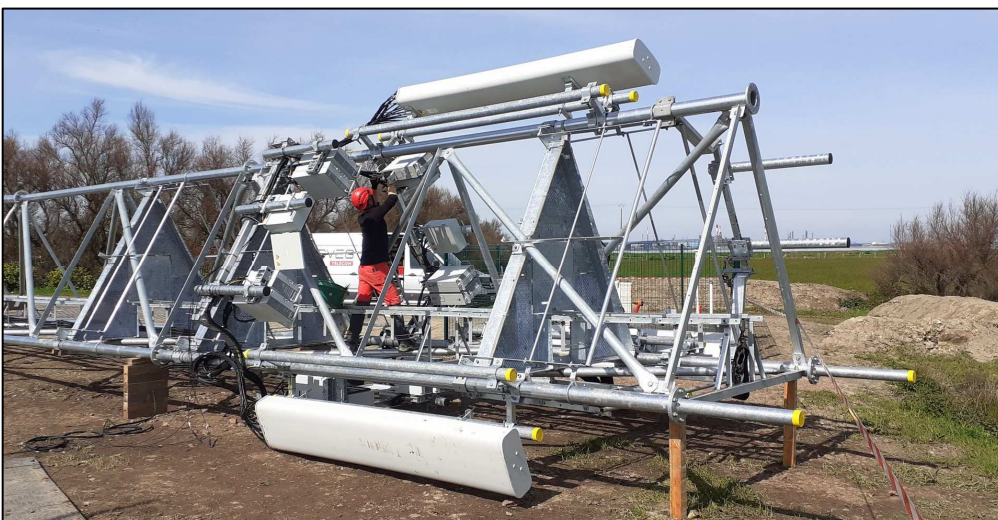
21 mars – Montage des antennes et modules de communication
