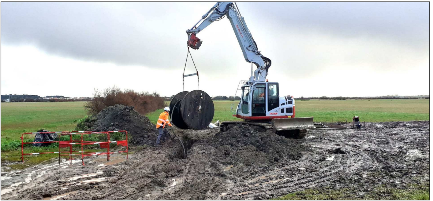
05 mars – Enfouissement du câble d'alimentation électrique
