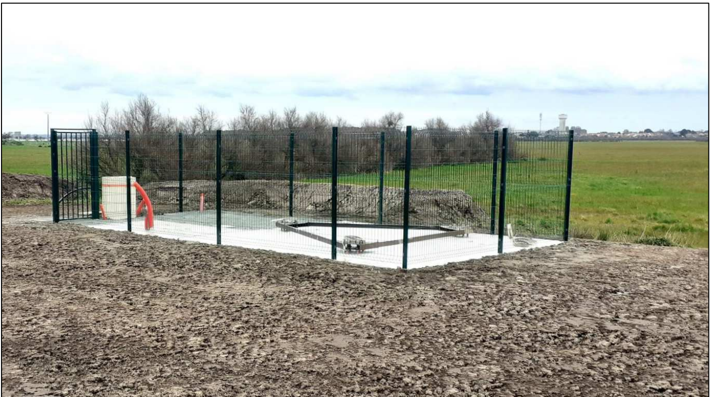
09 mars – Dalle, sabots de soutien et emprise terminés
