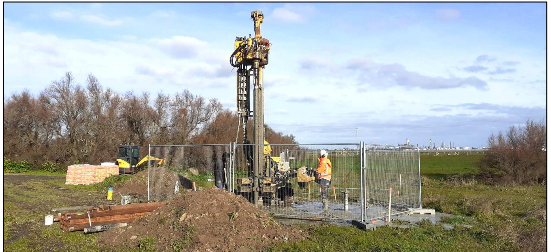
27 février – Forage pour mise en place des micropieux
