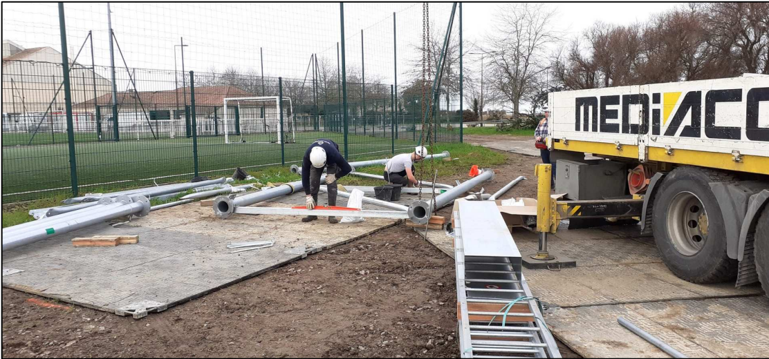
19 mars – Assemblage du pylône
