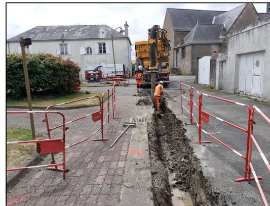
Réalisation d'une tranchée pour le passage des câbles électriques
